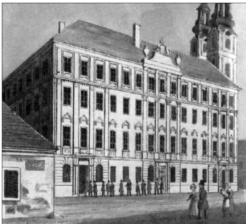
15. ábra. A nagyszeminárium épülete
